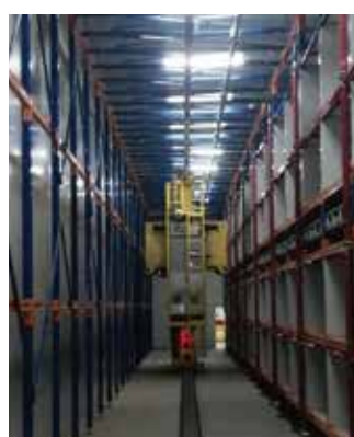
某项目模组充放电测试库
