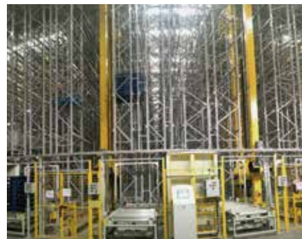
某项目堆垛机托盘库
